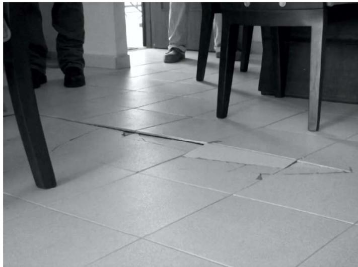
**Figura 6. Falla en revestimientos de cerámica en pisos.**
