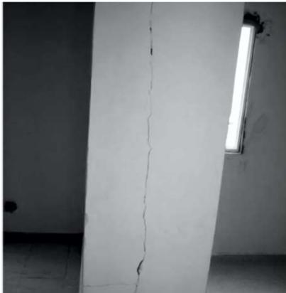
**Figura 4. Falla en columnas.**
