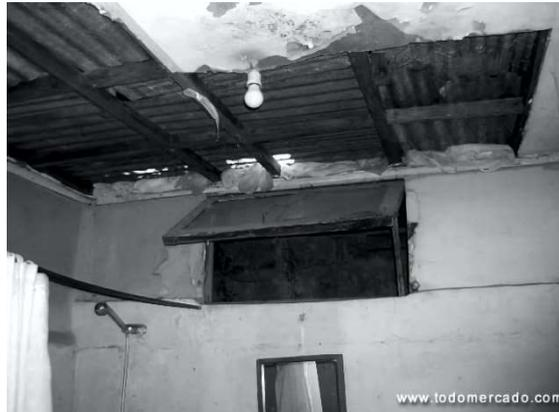
**Figura 5. Impermeabilización inadecuada.**
