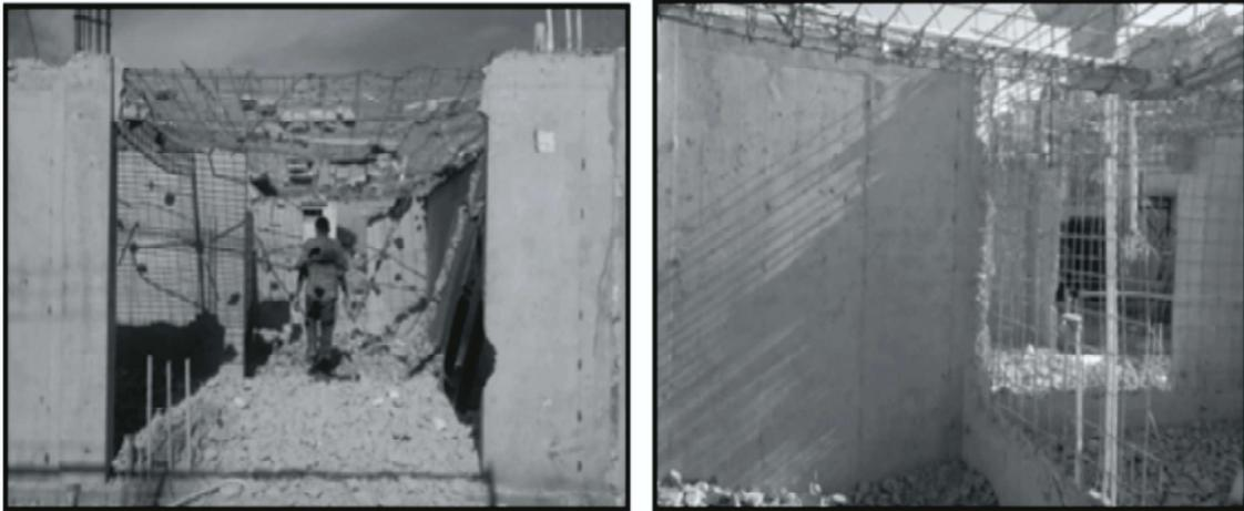
**Figura 2. Contaminación en la mezcla del concreto.**
