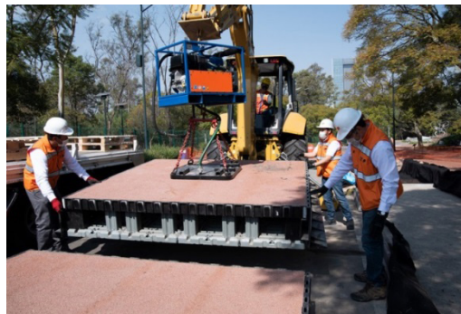
Figura 2. Ciclovía con plástico reciclado [11]
